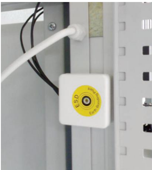
Рис.5. Коробка общей точки заземления
