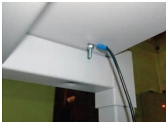
Рис. 1. Заземляющий столешницу винт, выполненный из металла
